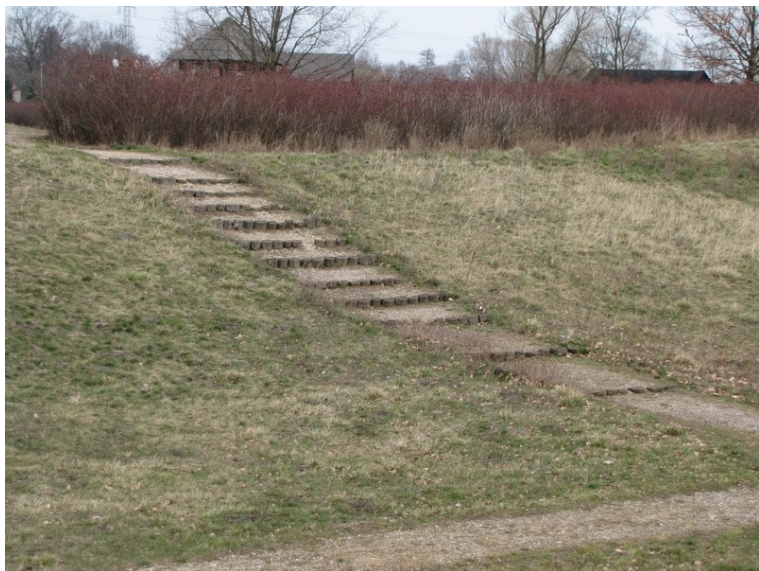
Fot. 8. Schody terenowe.
